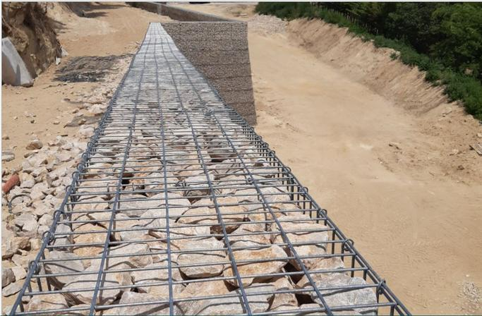
Garde corps en gabions électrosoudés
