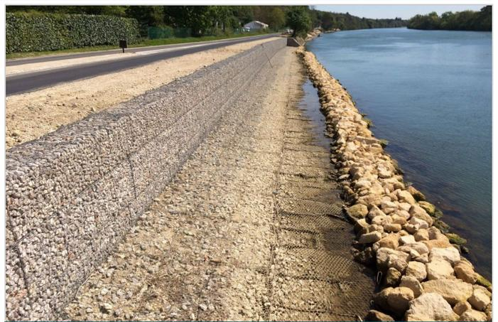
Gabions double torsion et Matelas Reno en protection contre l'érosion des berges
