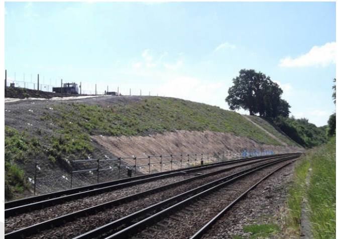
Steelgrid HR30 nach der Installation
