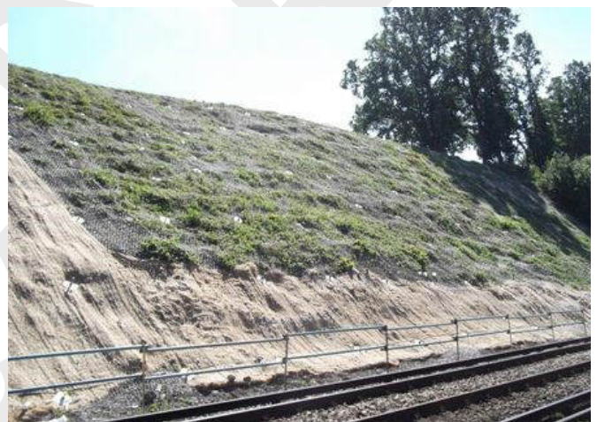
Steelgrid HR30 nach der Installation
