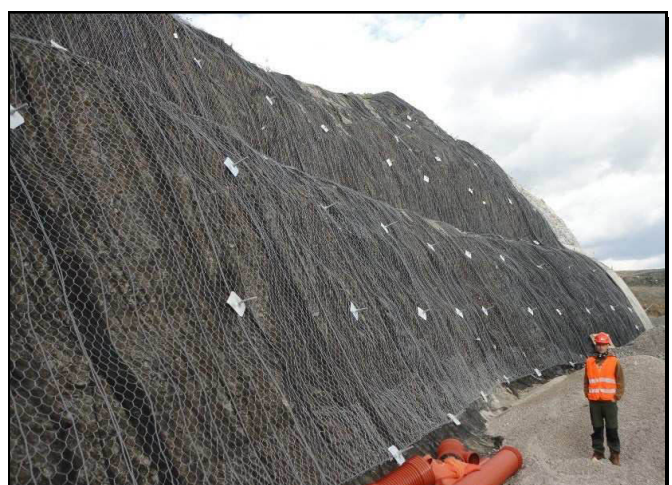
Nach der Installation
