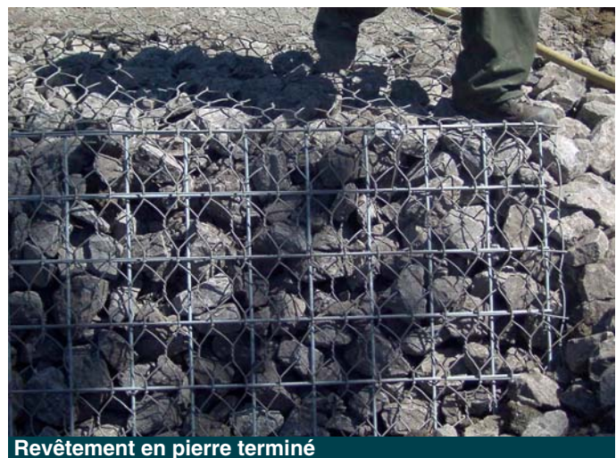
Revêtement en pierre terminé
