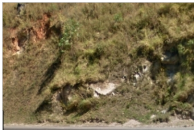
Antes da Obra
