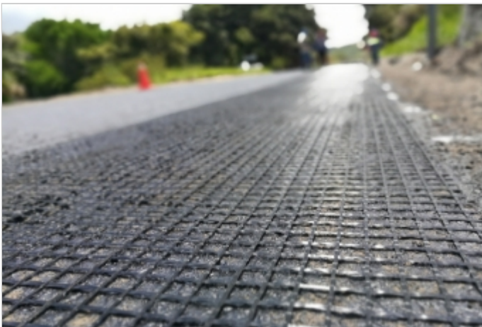
Durante la Obra
