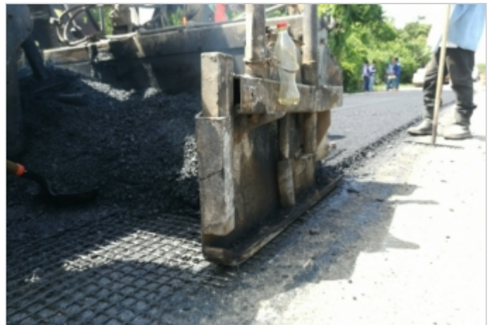
Durante la Obra
