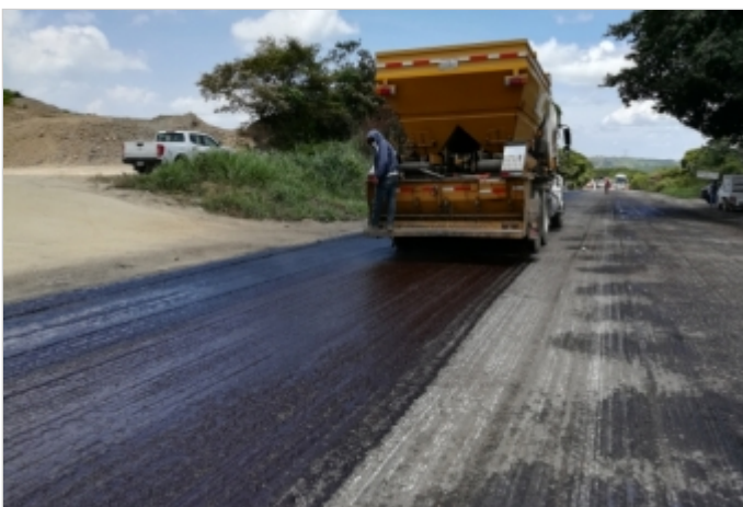
Durante la Obra
