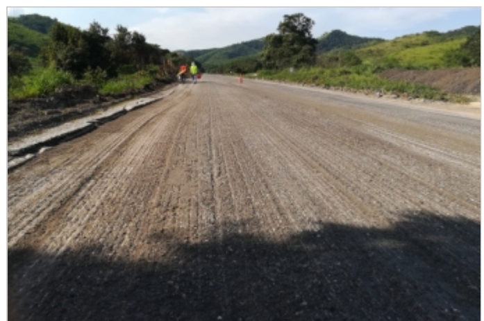
Durante la Obra
