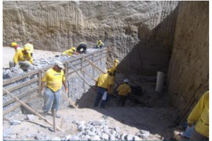
Durante la Obra
