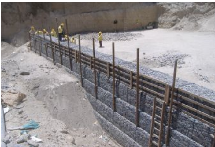
Durante la Obra
