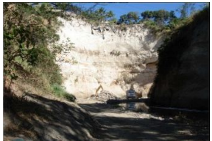
Durante la Obra
