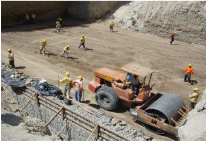
Durante la Obra
