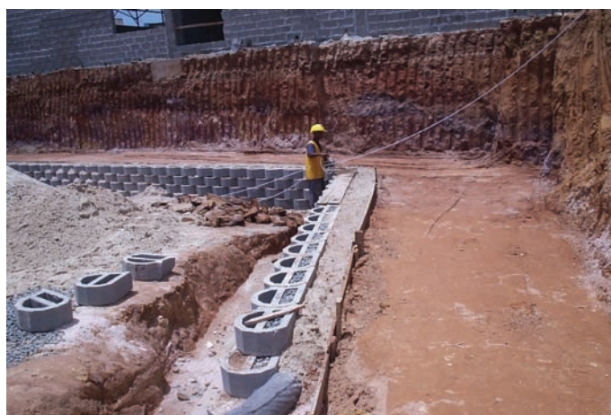
Durante la obra
