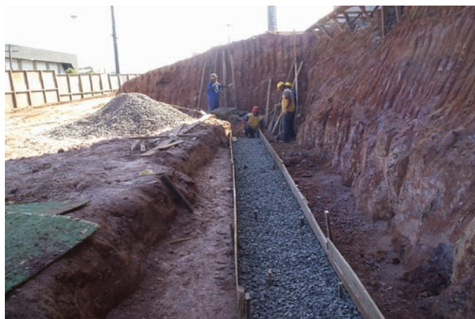
Durante la obra
