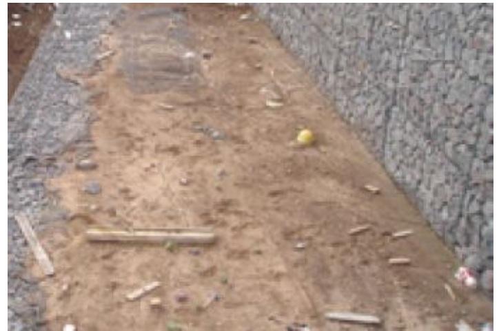
Durante la Obra
