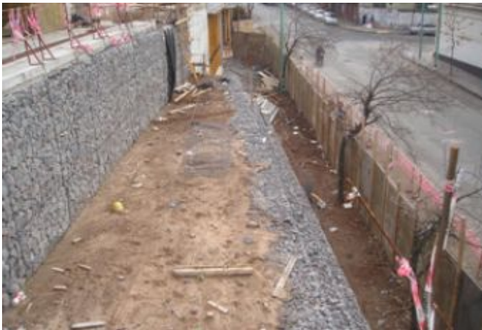
Durante la Obra
