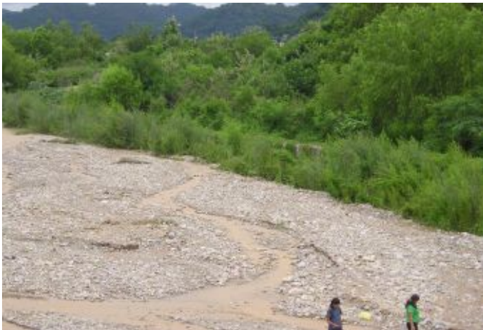
Durante la Obra
