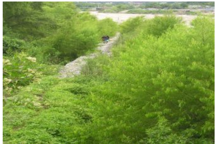
Durante la Obra
