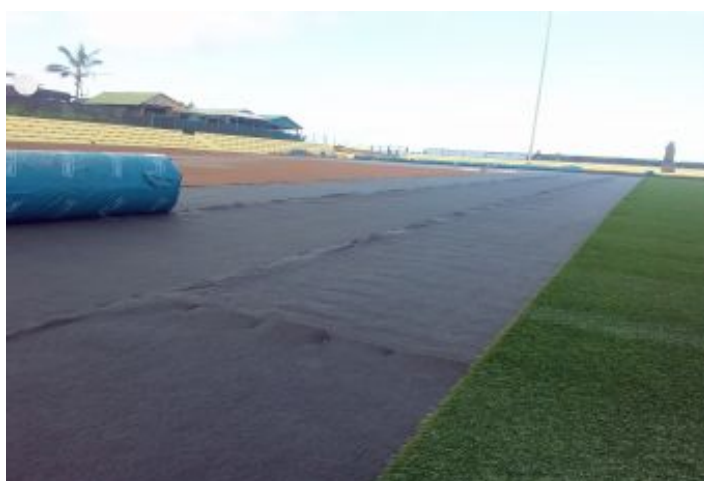
Durante la Obra
