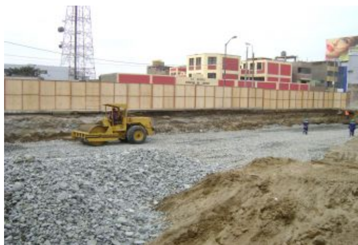
Durante a obra
