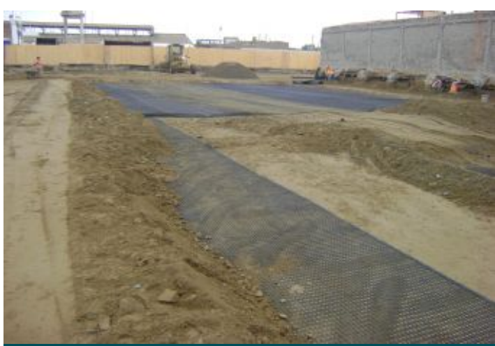
Durante a obra
