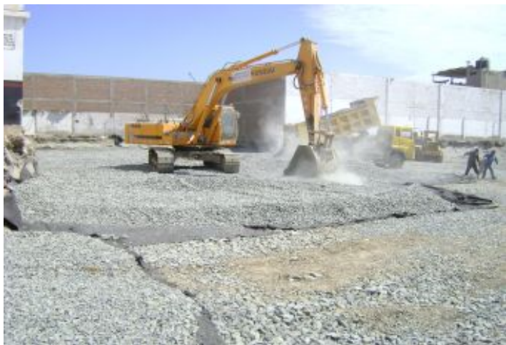
Durante a obra
