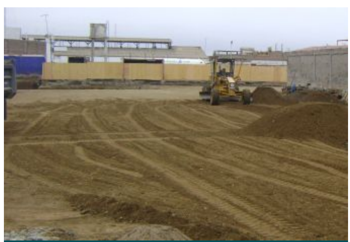
Durante a obra
