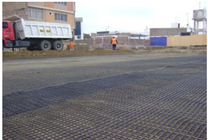
Durante a obra
