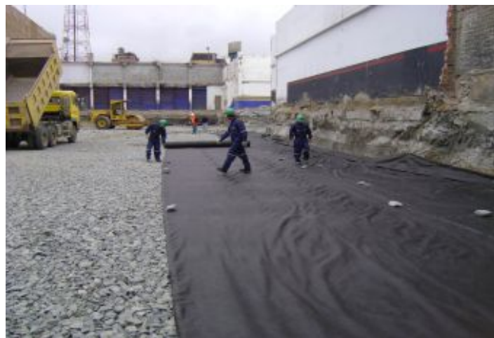
Durante a obra
