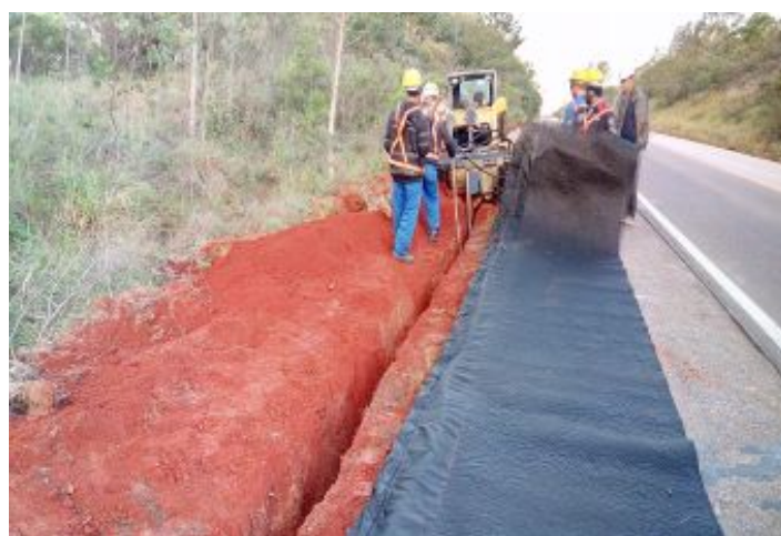
Durante a obra
