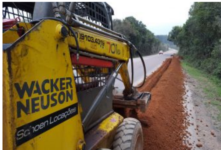
Durante a obra
