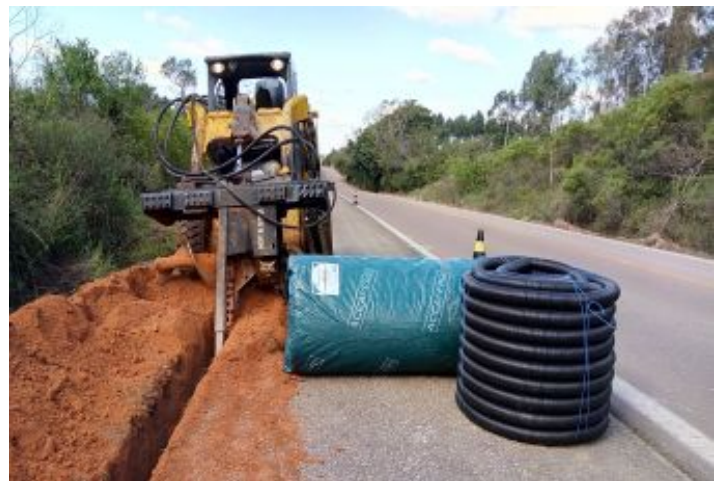
Durante a obra
