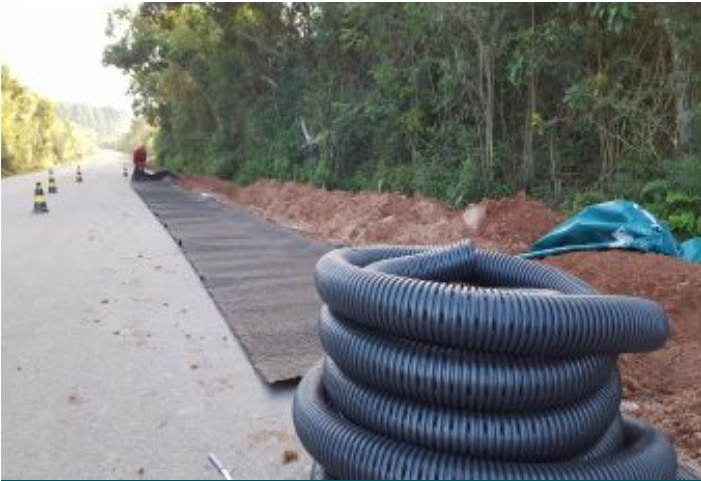
Durante a obra
