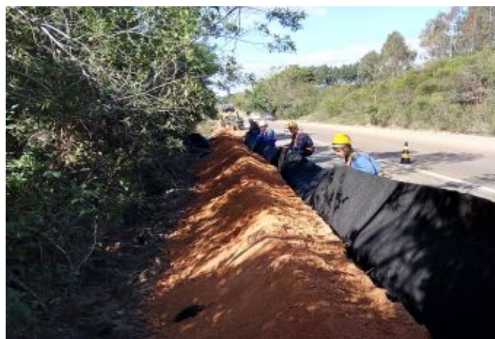
Durante a obra
