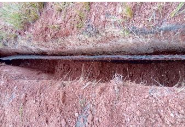
Durante a obra
