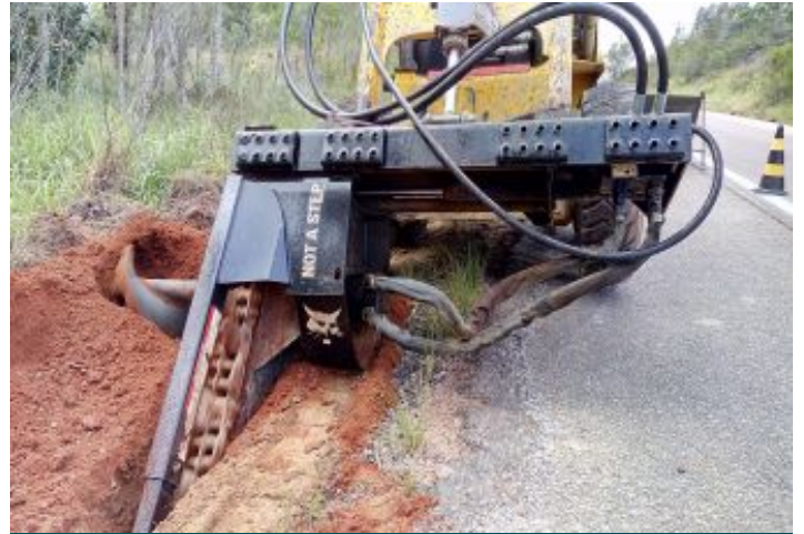
Durante a obra
