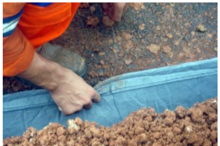
Durante a obra
