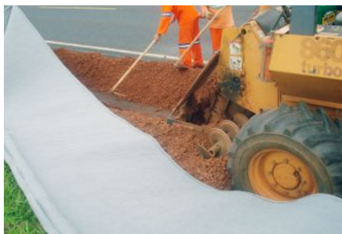
Durante a obra
