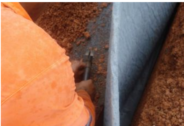
Durante a obra
