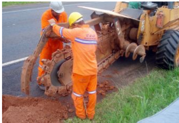
Durante a obra
