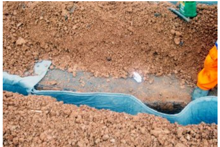
Durante a obra
