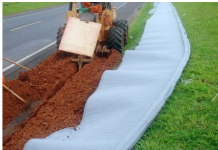
Durante a obra
