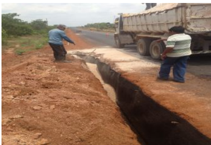
Durante la Obra
