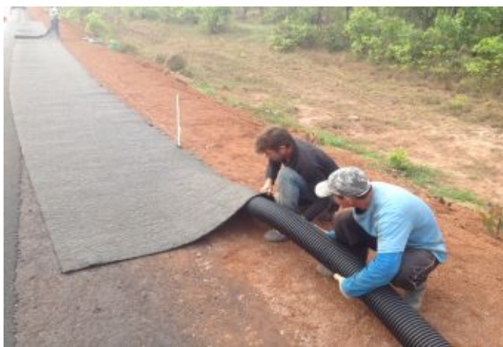
Durante la Obra
