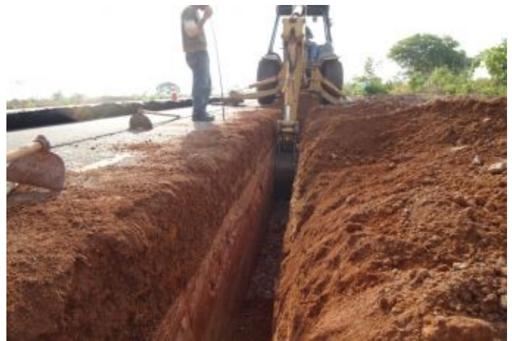
Durante la Obra
