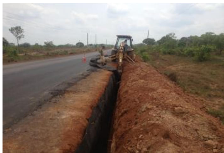
Durante la Obra
