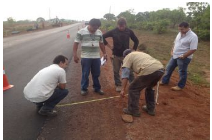
Durante la Obra
