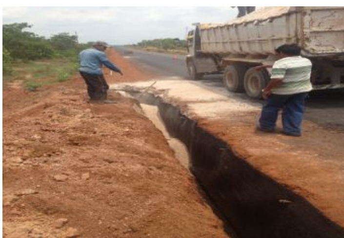
Durante a obra
