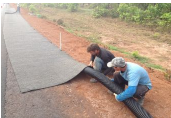
Durante a obra
