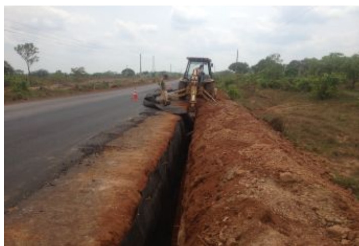
Durante a obra
