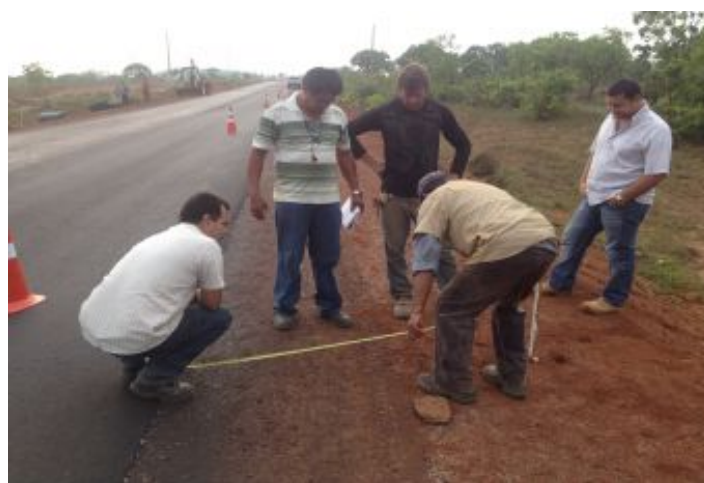
Durante a obra
