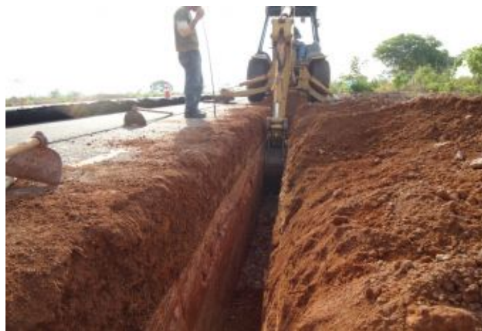
Durante a obra
