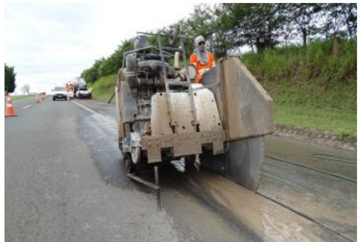
Durante a obra
