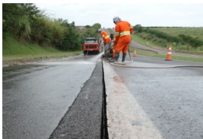
Durante a obra
