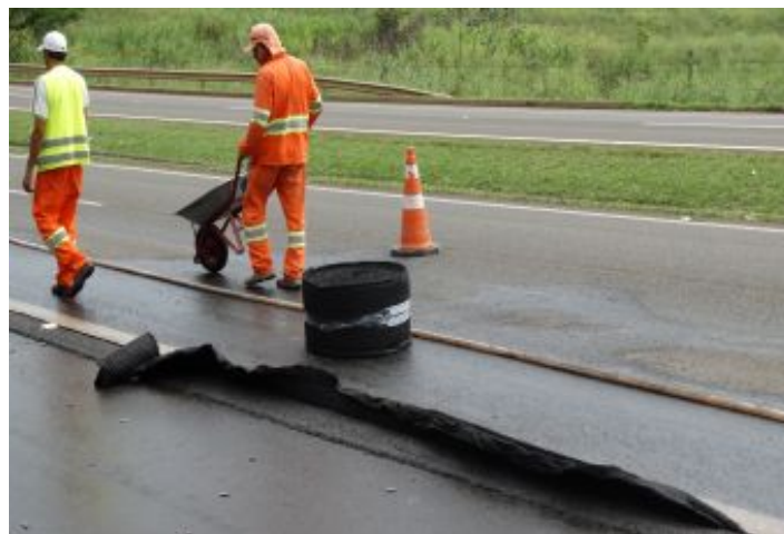
Durante a obra
