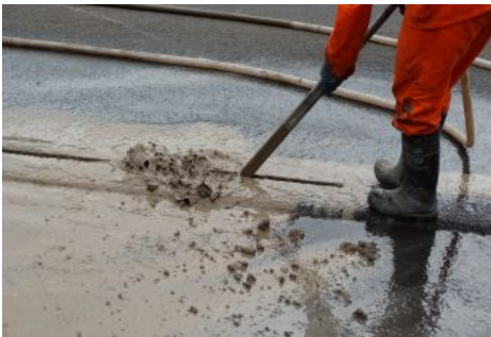
Durante a obra
