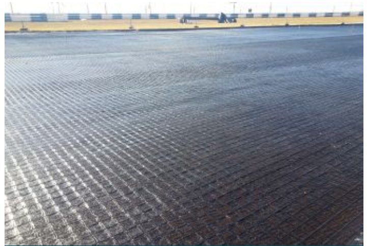
Durante la Obra
