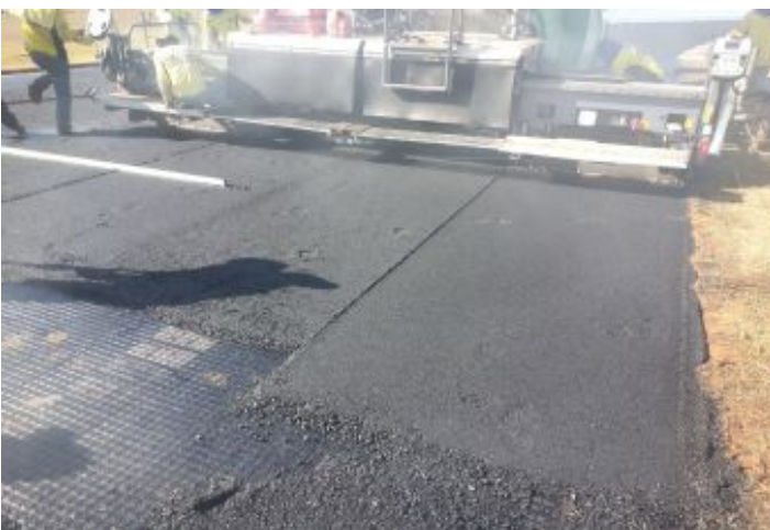
Durante la Obra
