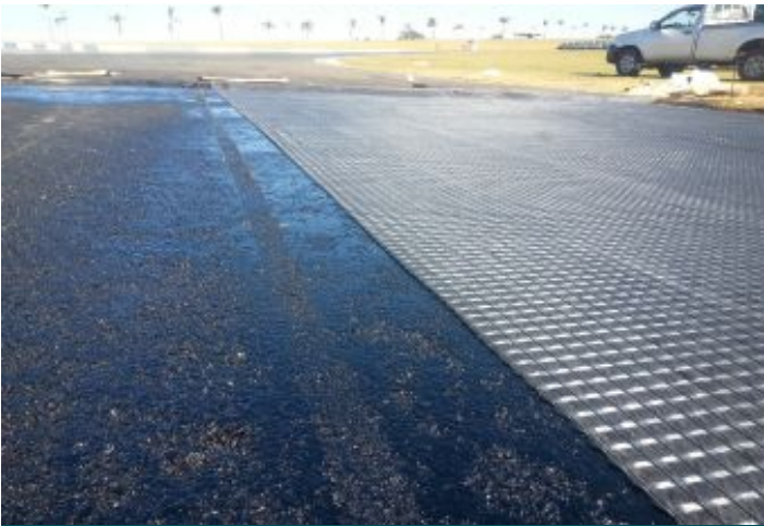
Durante la Obra
