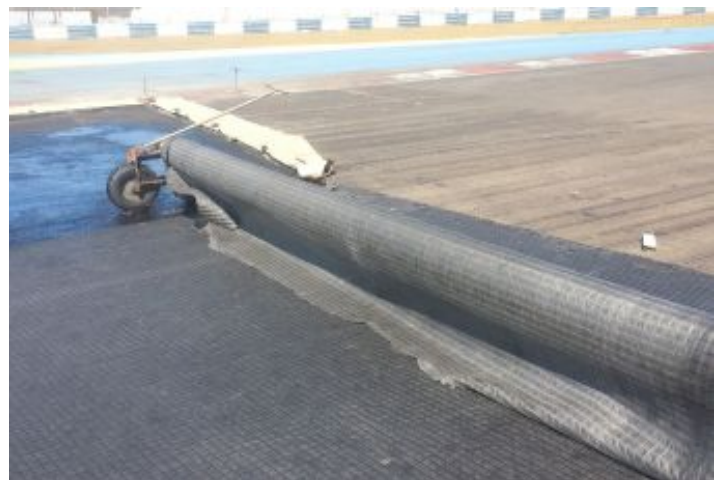
Durante la Obra
