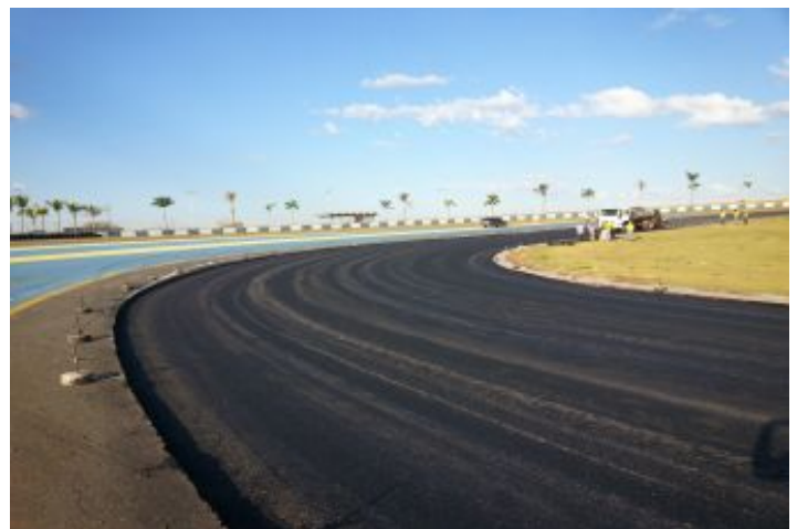
Durante la Obra
