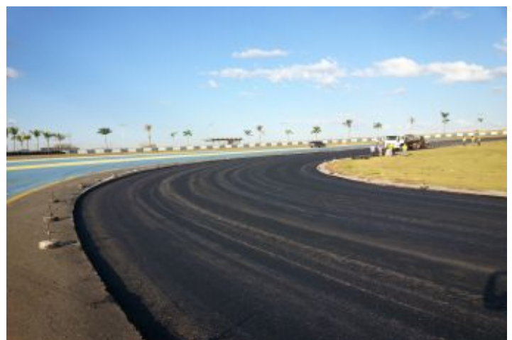
Durante a obra
