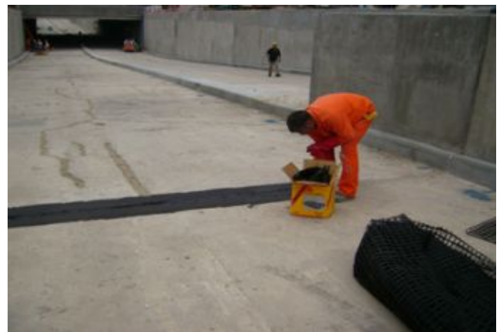
Durante la Obra
