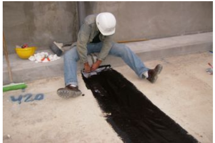
Durante la Obra
