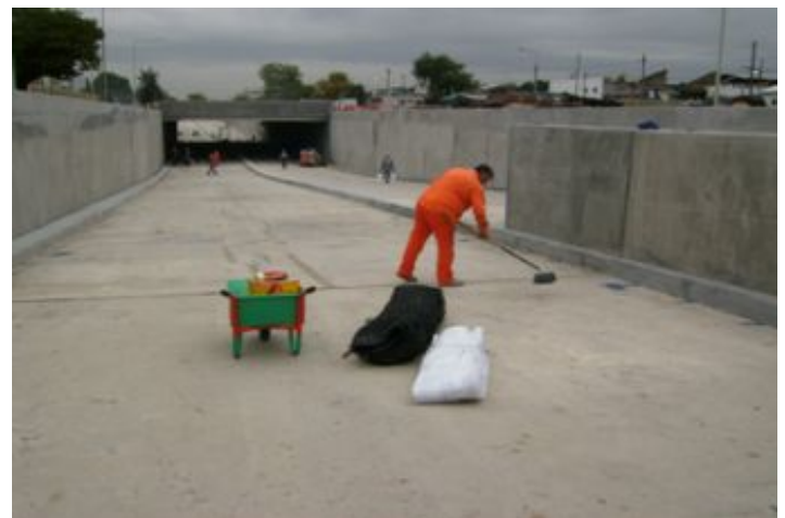
Durante la Obra
