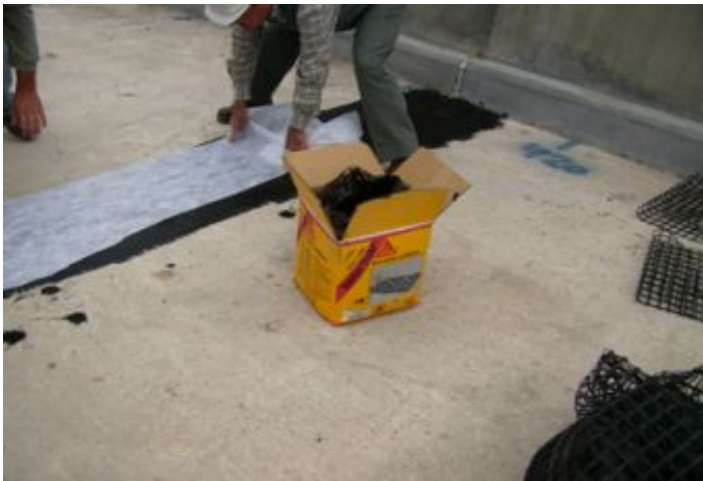
Durante la Obra
