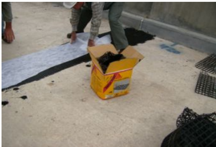
Durante a obra
