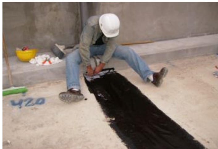
Durante a obra
