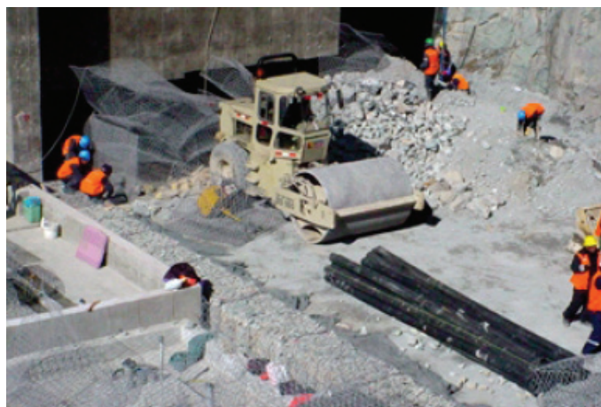
Durante la obra
