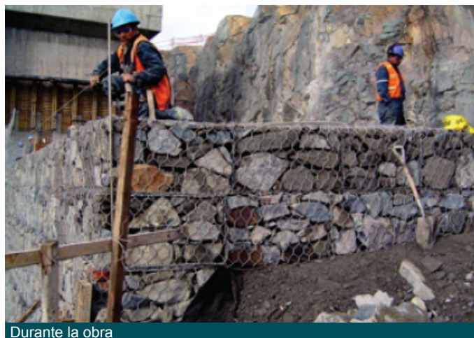
Durante la obra
