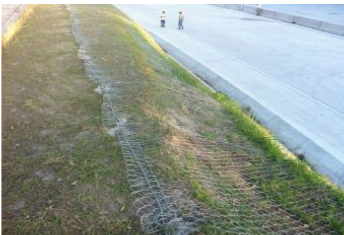
Durante la Obra
