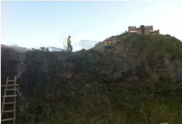
Durante la Obra
