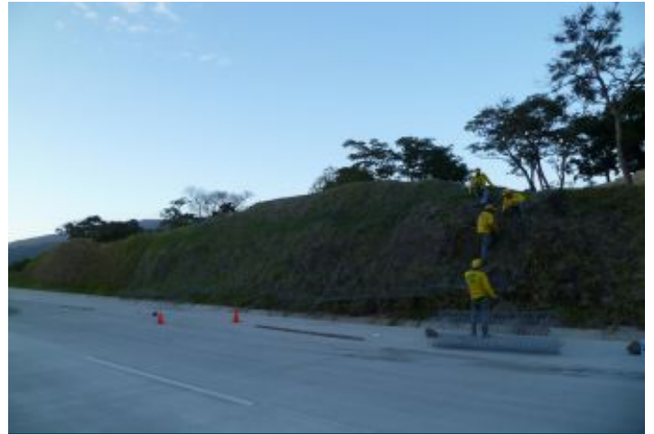
Durante la Obra
