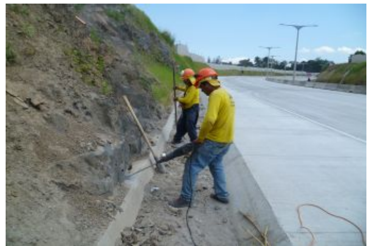
Durante la Obra
