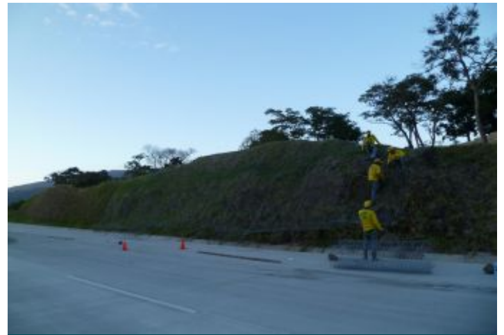
Durante a obra
