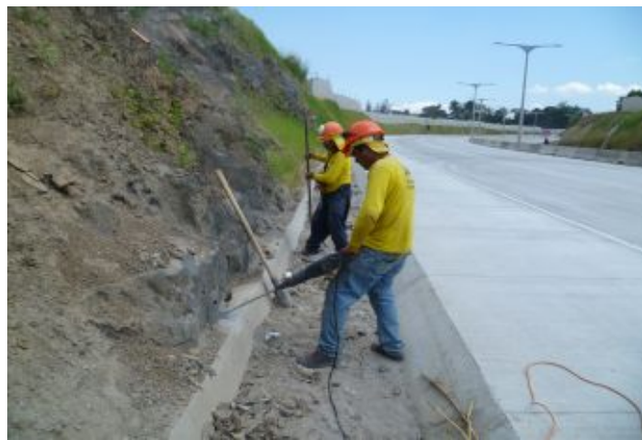
Durante a obra
