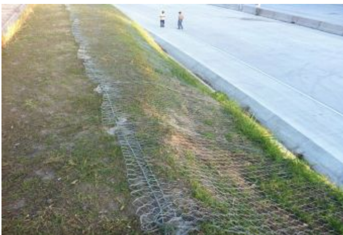
Durante a obra
