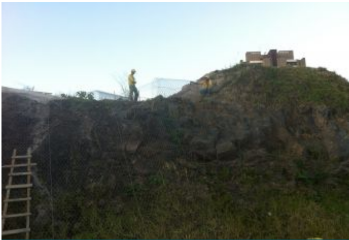
Durante a obra
