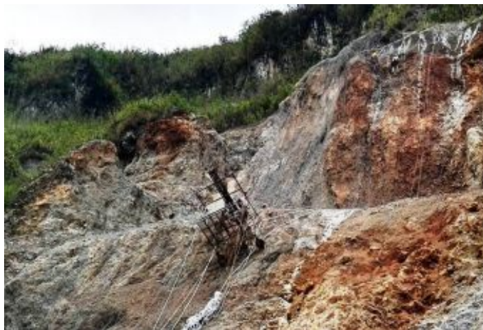
Durante a obra
