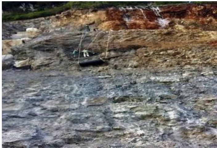
Durante a obra
