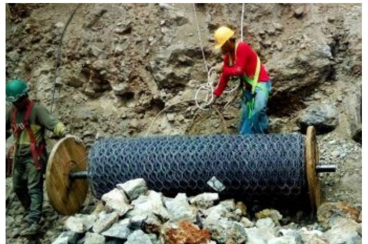
Durante a obra
