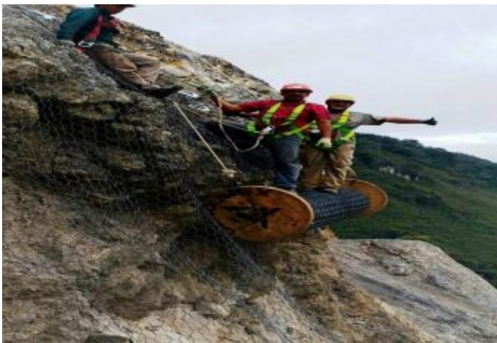
Durante a obra
