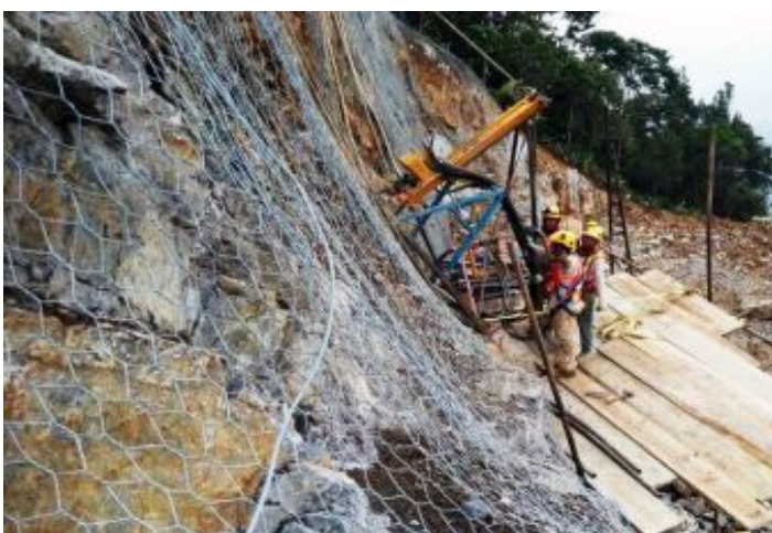
Durante a obra
