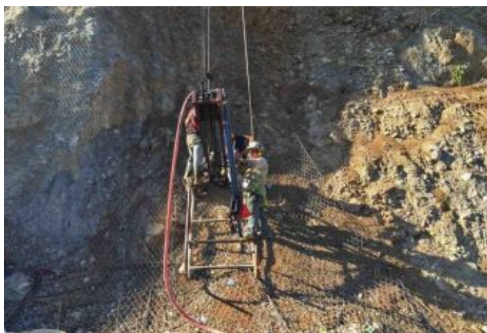
Durante a obra
