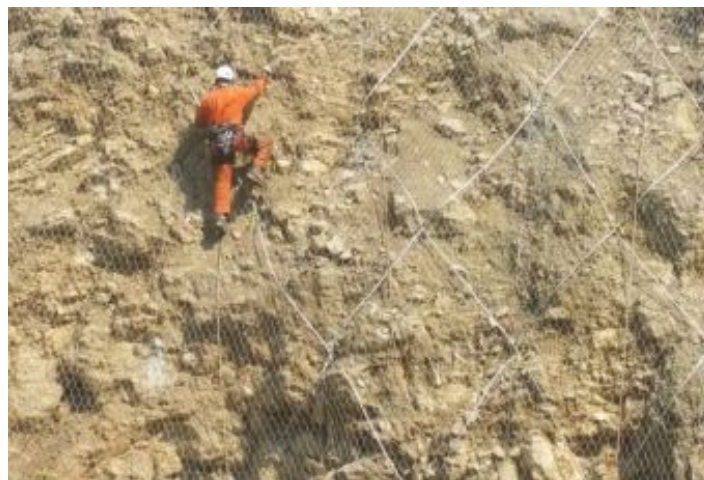
Durante la Obra
