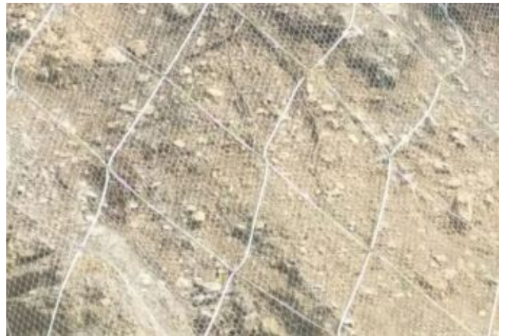
Durante la Obra
