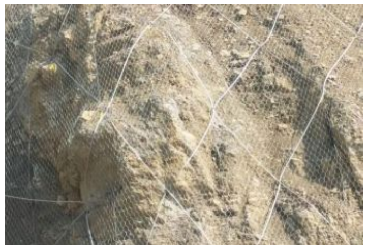
Durante la Obra
