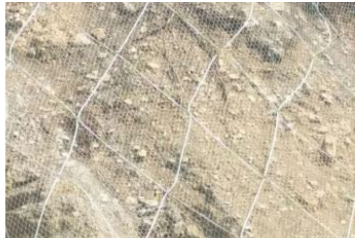
Durante a obra
