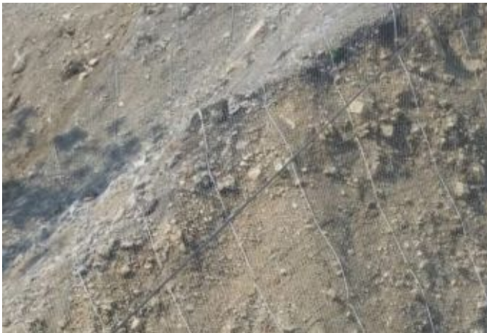
Durante a obra
