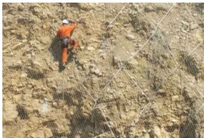
Durante a obra
