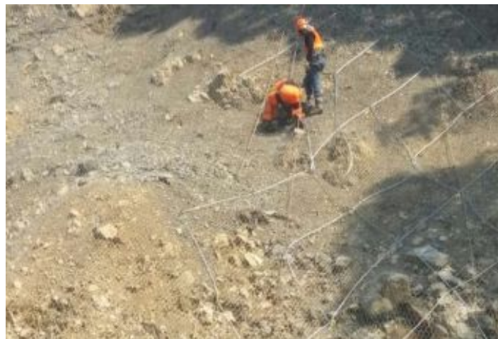
Durante a obra
