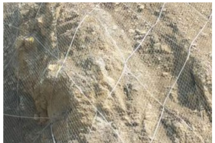
Durante a obra
