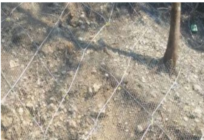
Durante a obra
