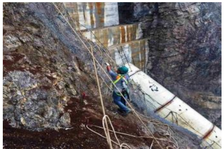
Durante la Obra
