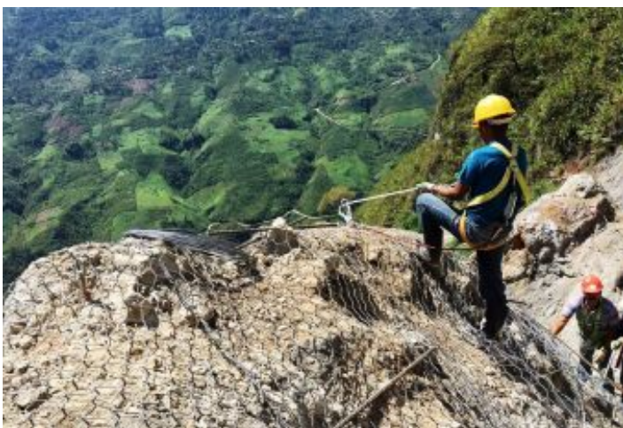
Durante la Obra
