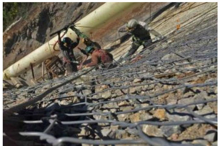
Durante la Obra
