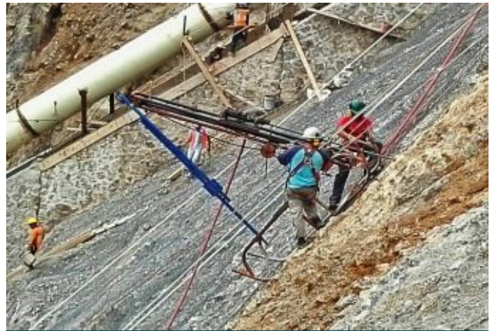
Durante la Obra
