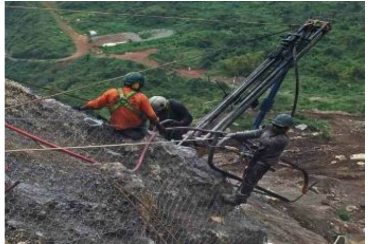
Durante la Obra
