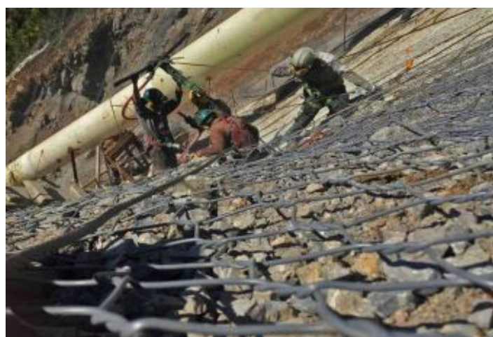
Durante a obra
