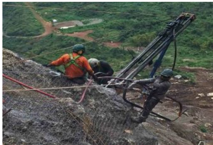
Durante a obra
