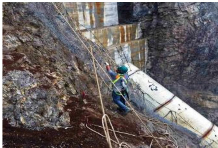
Durante a obra
