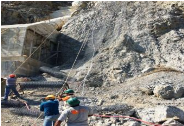
Durante a obra
