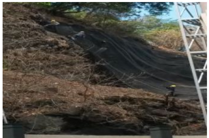
Durante la Obra
