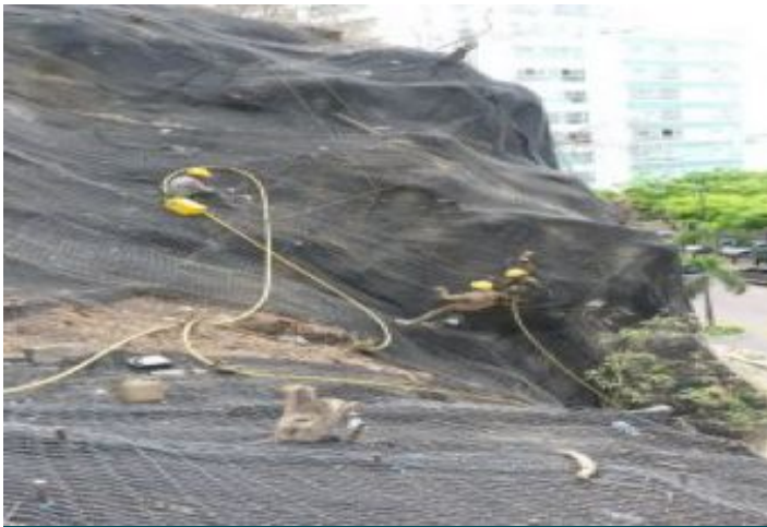
Durante la Obra
