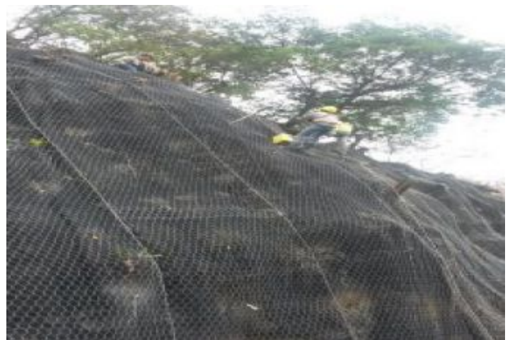
Durante la Obra
