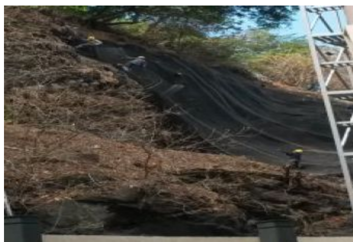
Durante a obra
