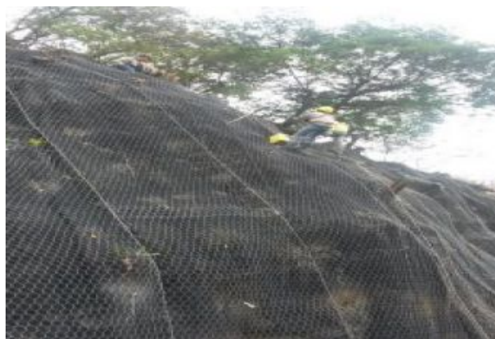
Durante a obra
