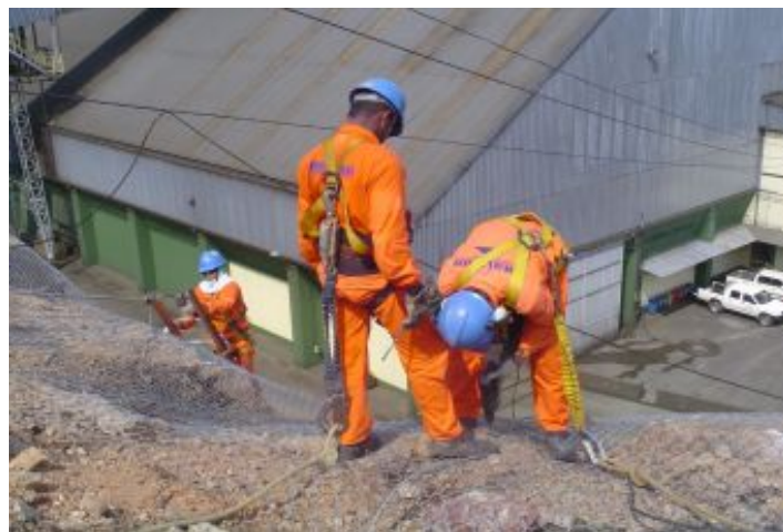
Durante a obra
