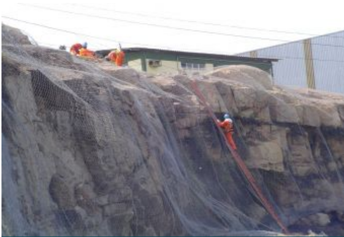
Durante a obra
