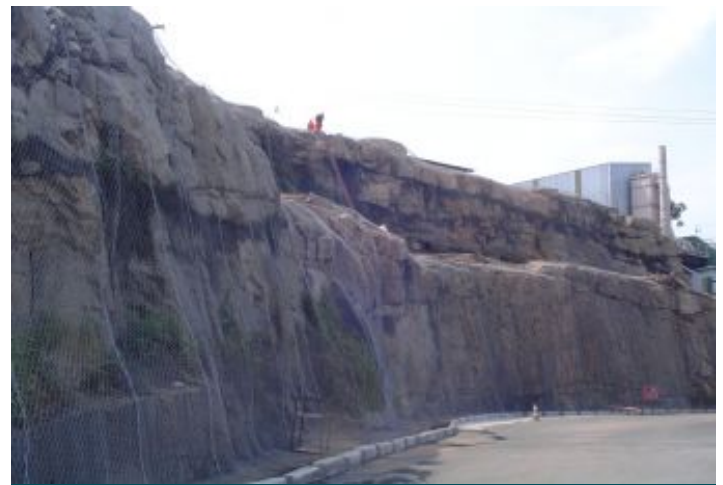
Durante a obra
