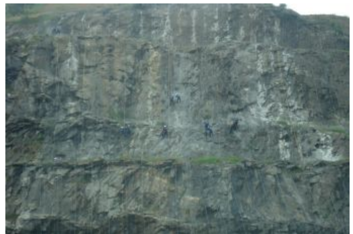
Durante a obra
