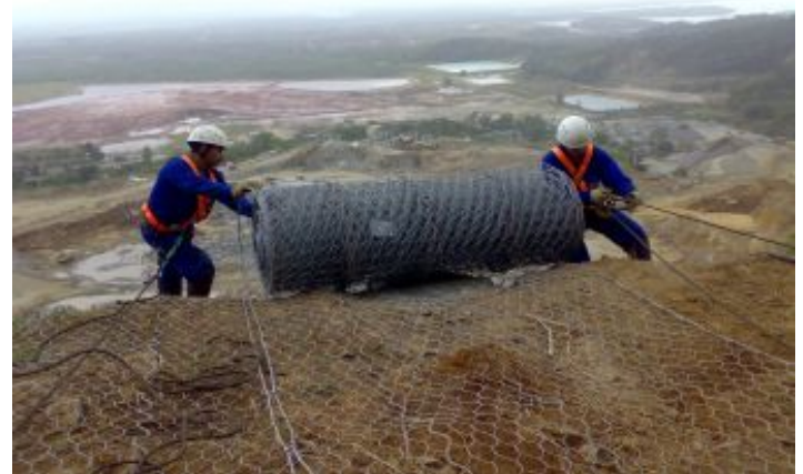
Durante a obra
