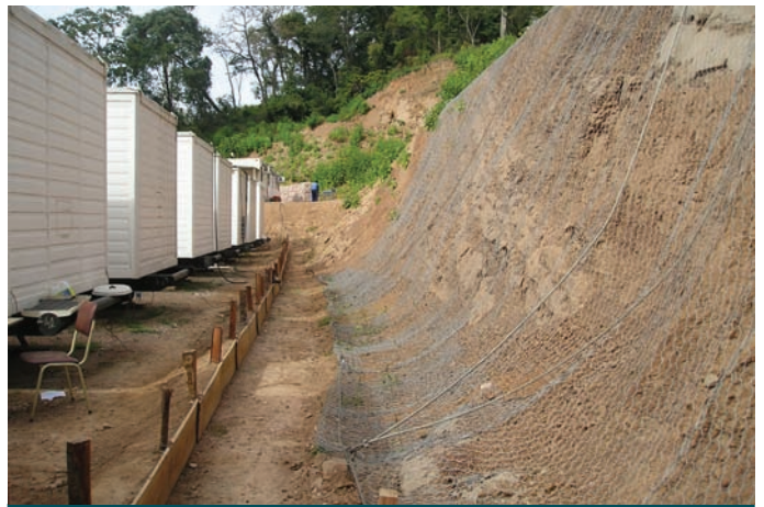
Durante la obra
