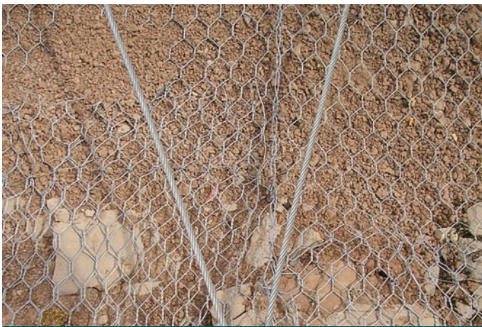
Durante la obra
