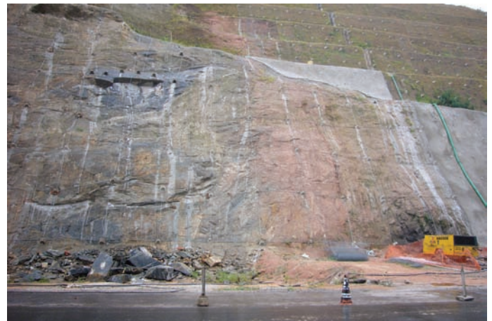
Durante la obra
