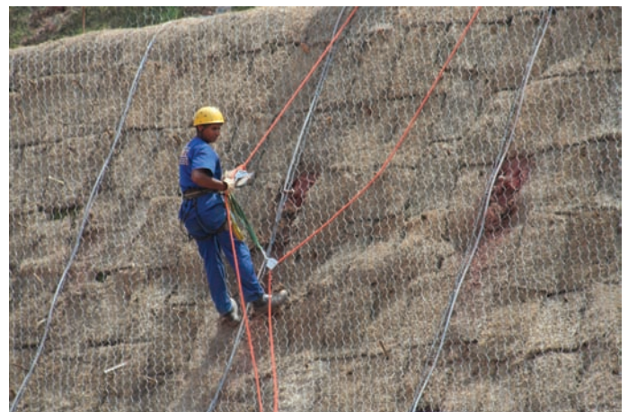
Durante la obra
