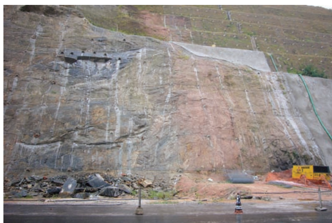
Durante a obra
