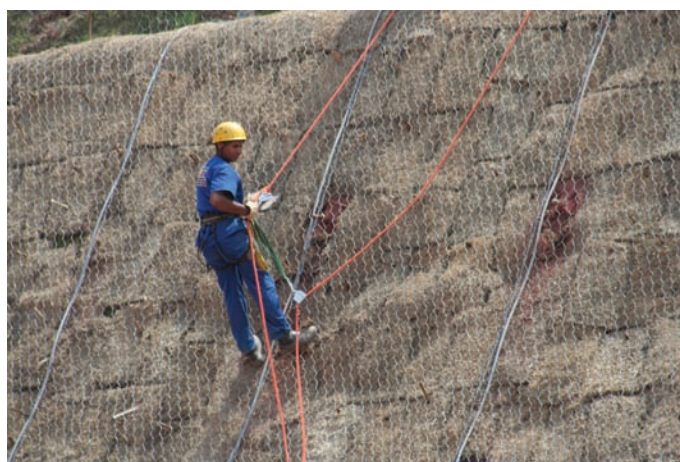
Durante a obra
