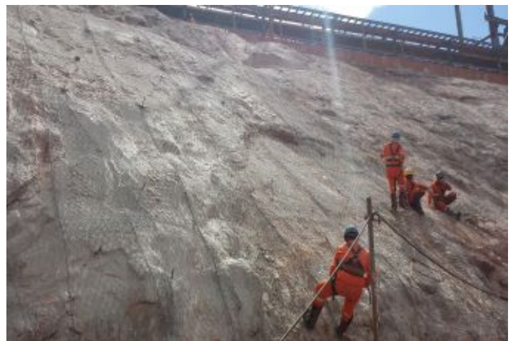
Durante la Obra
