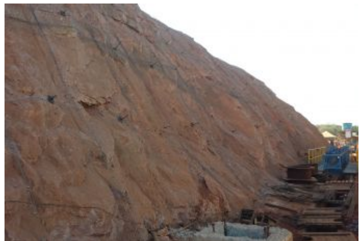
Durante la Obra
