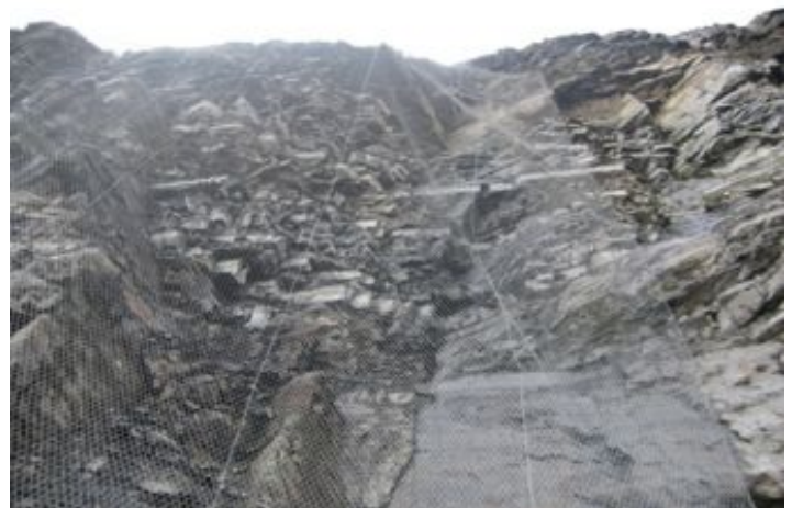
Durante a obra
