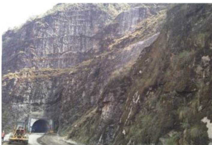
Durante a obra
