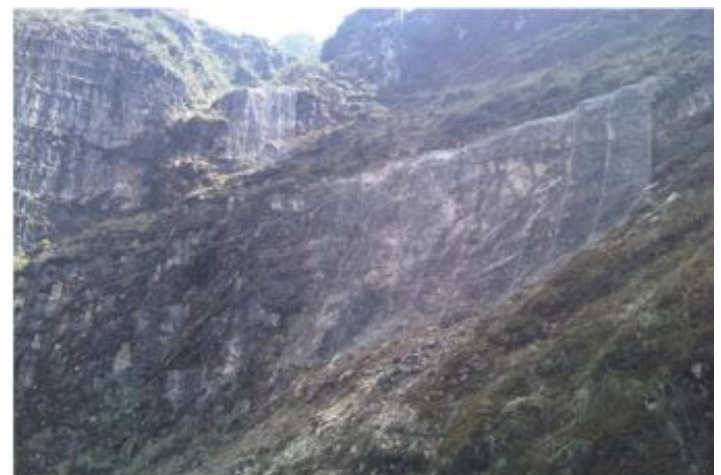
Durante a obra
