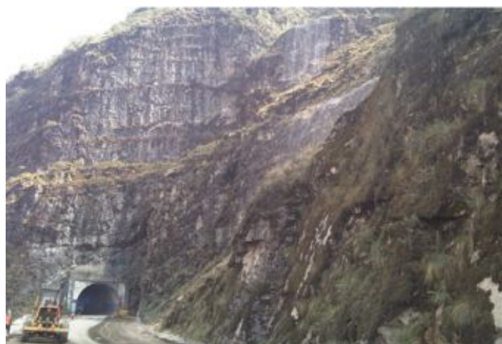
Durante a obra
