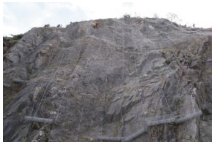
Durante a obra
