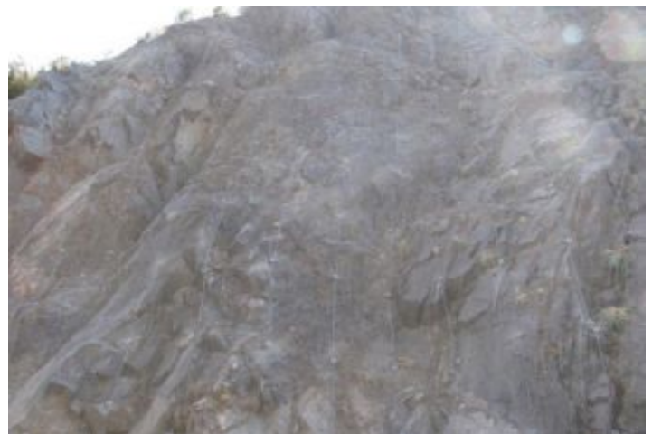
Durante a obra
