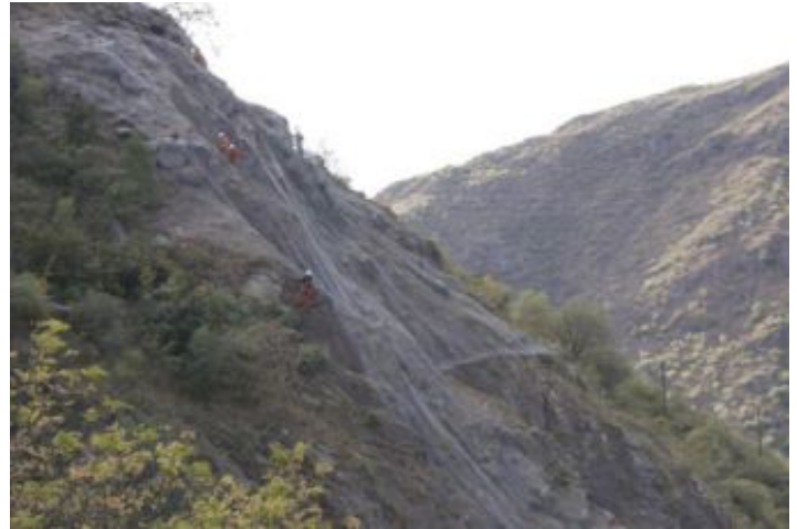
Durante a obra
