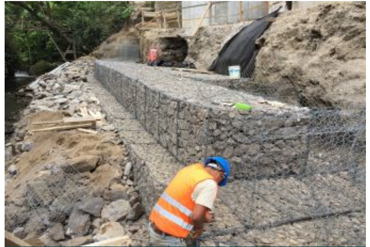
Durante la Obra
