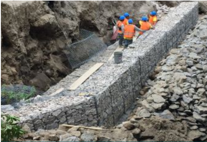
Durante la Obra
