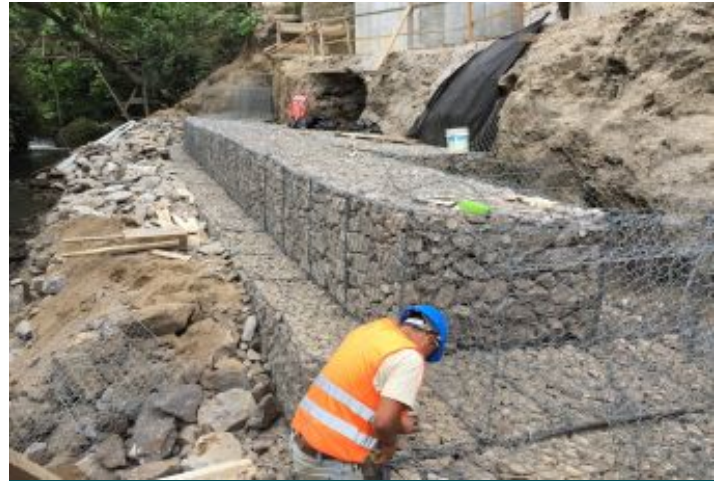
Durante a obra
