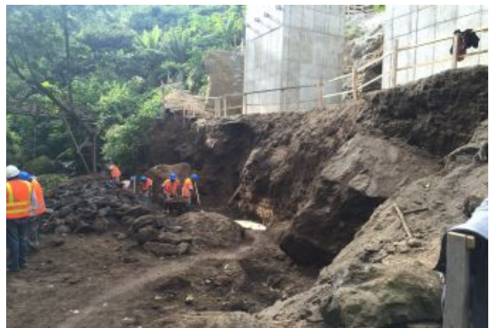
Durante a obra
