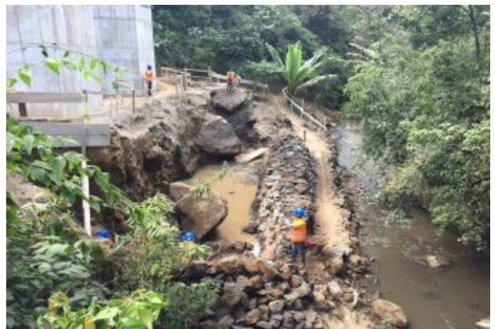
Durante a obra
