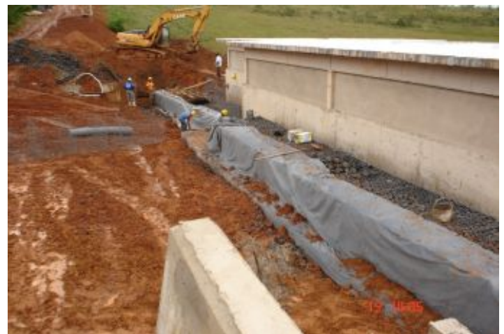
Durante la Obra
