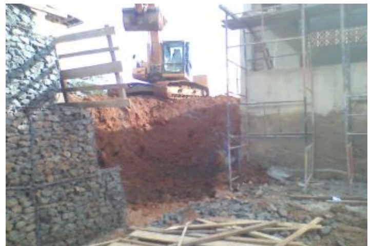
Durante la Obra
