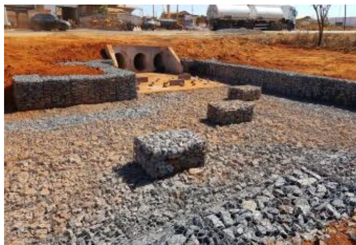
Durante a obra
