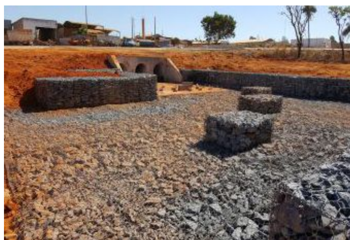
Durante a obra
