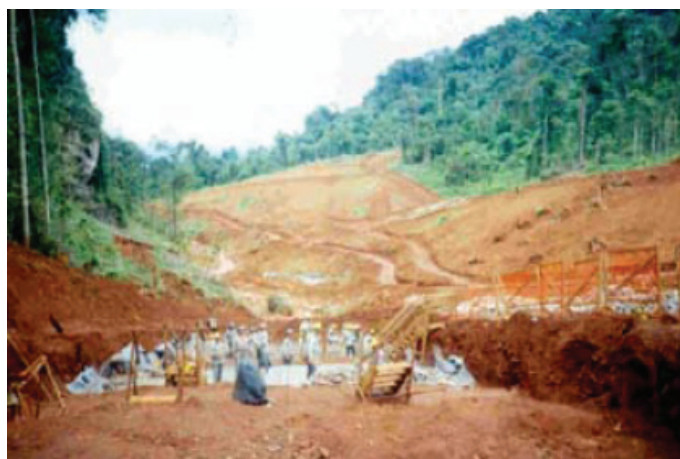
Durante a obra
