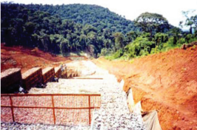
Durante a obra
