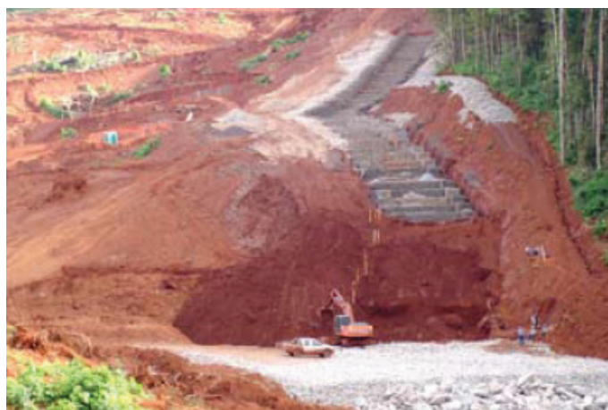
Durante a obra
