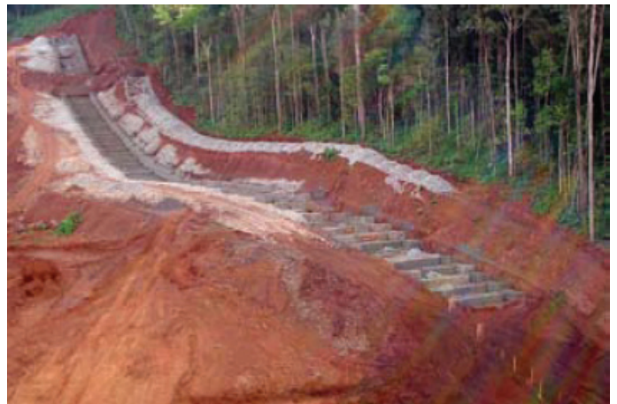
Durante a obra
