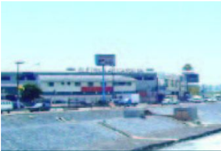
Durante a obra
