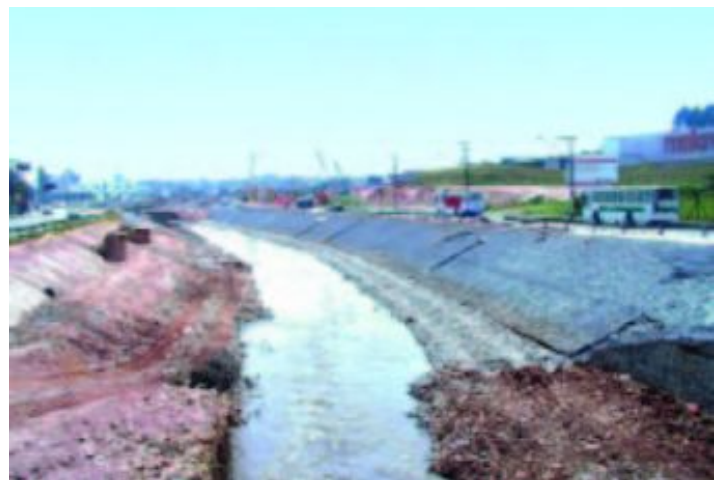
Durante a obra
