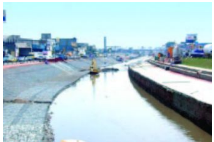
Durante a obra
