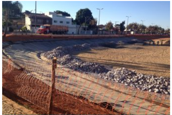
Durante a obra
