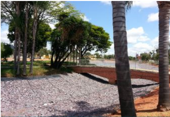
Durante a obra
