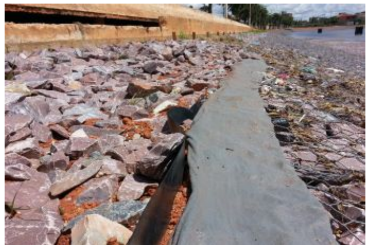
Durante a obra
