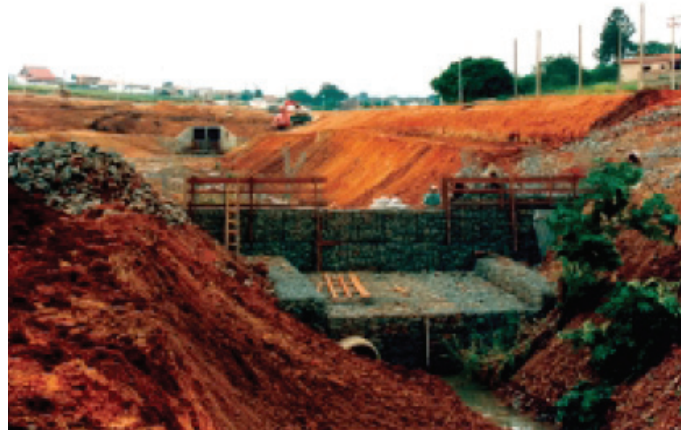
Durante la obra
