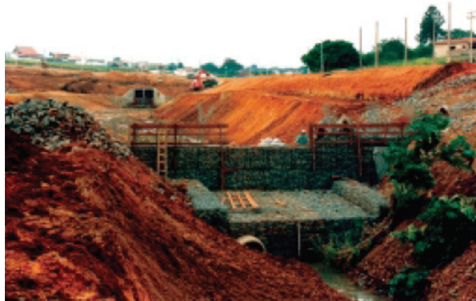
Durante a obra
