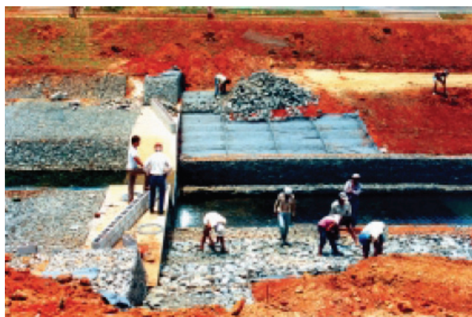
Durante a obra
