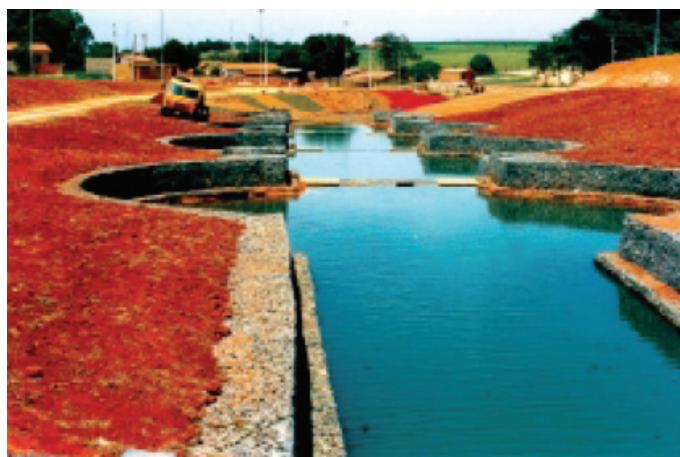
Durante a obra
