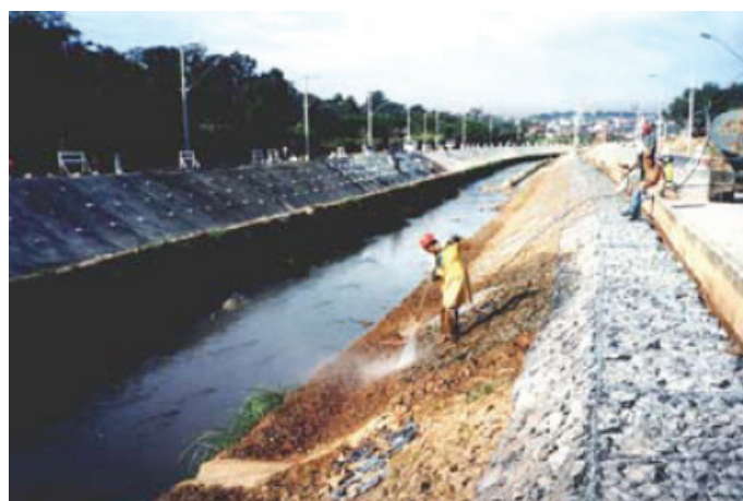
Durante la obra
