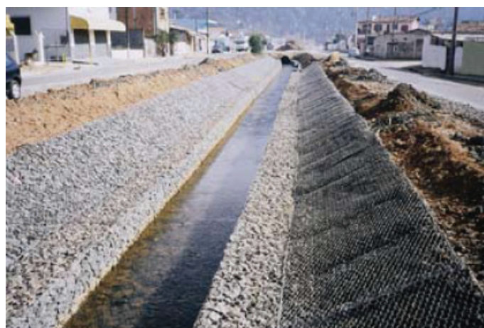
Durante la obra
